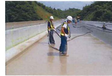
●吹き付け施工
